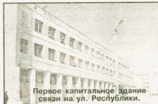
Первое капитальное здание связи на ул. Республики.
