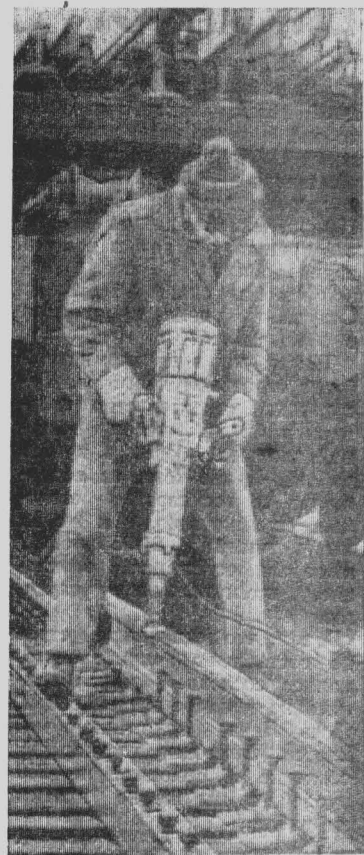
Юганская операция — пришивка рельсов к мостовому брусу: слева — бригада монтажников СМП-384 бригадира С. А. Кривохижи на мосту через Юганскую Обь.
