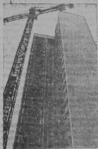
Строители экспериментального монтажного управления СКБ Прокатдеталь возвели в Тропареве новый 22-этажный жилой дом на 147 квартир. Дом оригинальной конструкции — крестообразный в плане — смонтирован из унифицированных деталей. Сейчас строители приступили к монтажу второго такого же дома.
