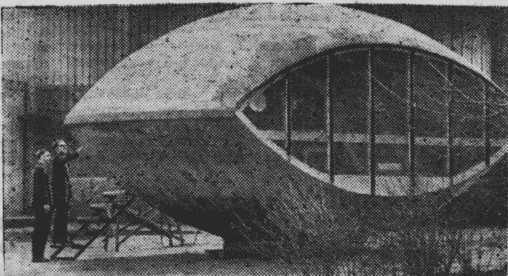
Ленинградским зональным научно-исследовательским и проектным институтом типового и экспериментального проектирования разработаны передвижные дома из армоконструкций скользящие для труднодоступных районов Севера. С виду такие дома напоминают линзу. Внутри же дом представляет собой комфортабельную квартиру площадью 30 квадратных метров.
