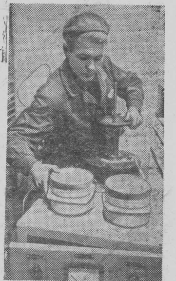
На заводе электротермического оборудования в Новосибирске налажен выпуск электродно-водогрейных котлов. Небольшие по габаритам и весу котлы нагревают воду с помощью электричества до любой температуры автоматически по заданной программе.
