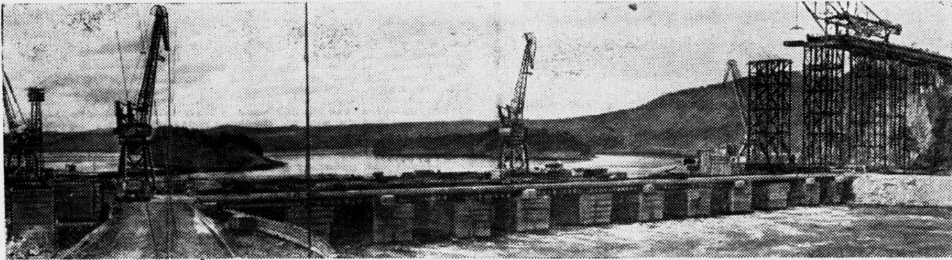
Соревнуясь за достойную встречу XXIV съезда КПСС, строители Усть-Илимской ГЭС решили дополнительно к плану 1970 года уложить в основание плотины тысячи кубометров бетона. Десятки самосвалов, бульдозеров, экскаваторов работают в эти дни в котловане. Ведется монтаж большой бетоновозной эстакады. Скоро начнется укладка бетона в тело плотины.
