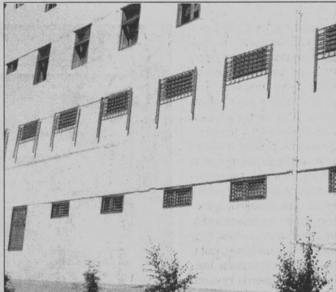
Ремонт ремонту рознь
