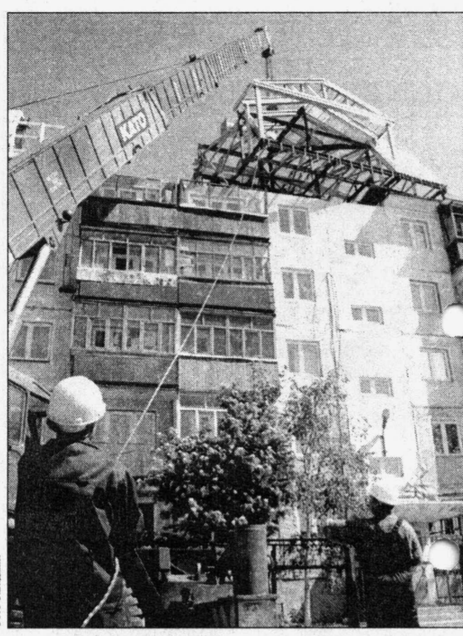
Мансарда в процессе создания
