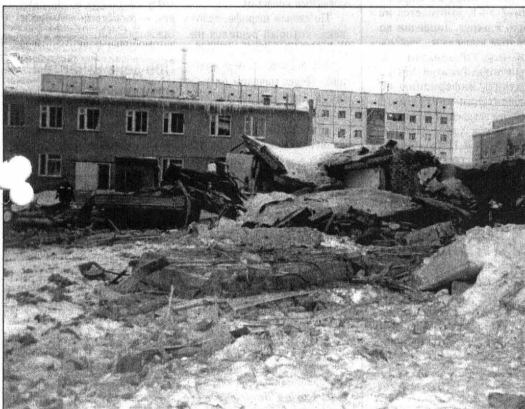
Последствия взрыва газового оборудования на станции переливания крови.
