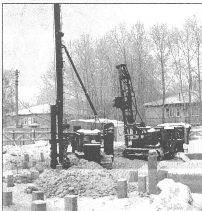
Вот оно близкое соседство новостройки с жильем.
