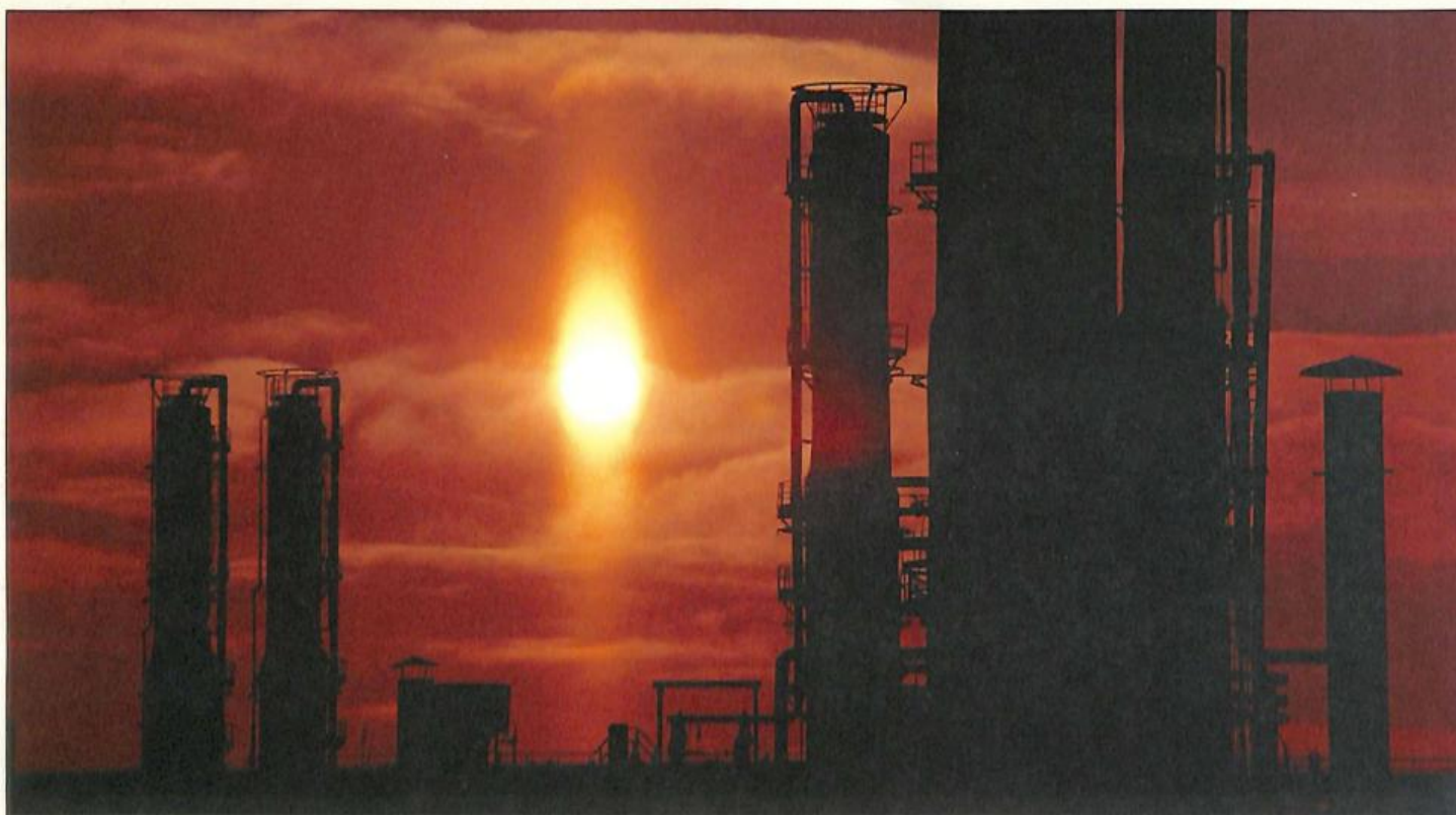
Завод стабилизации газового конденсата Gas-processing factory
