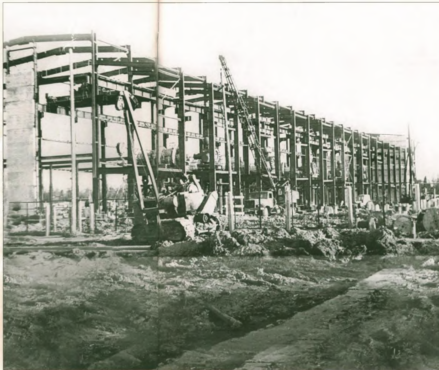
Туртасская КС. Строится цех
