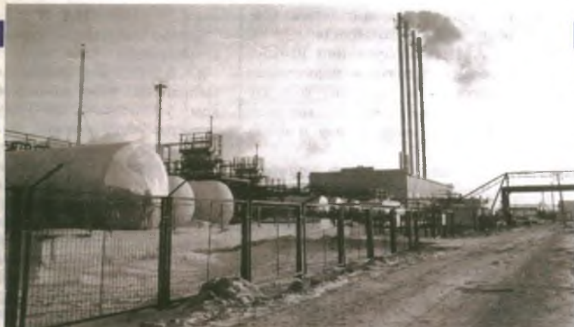
На снимке: Западно-Таркосалинский газовый промысел.
