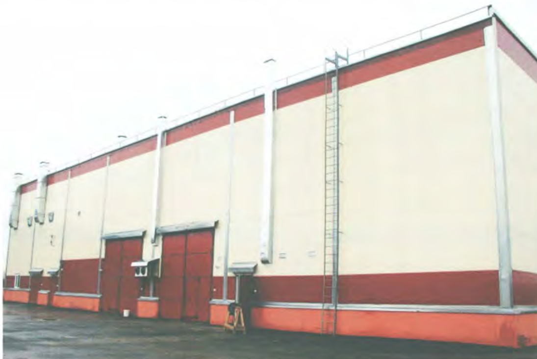
Комплекс по термическому обезвреживанию медицинских и биологических отходов
