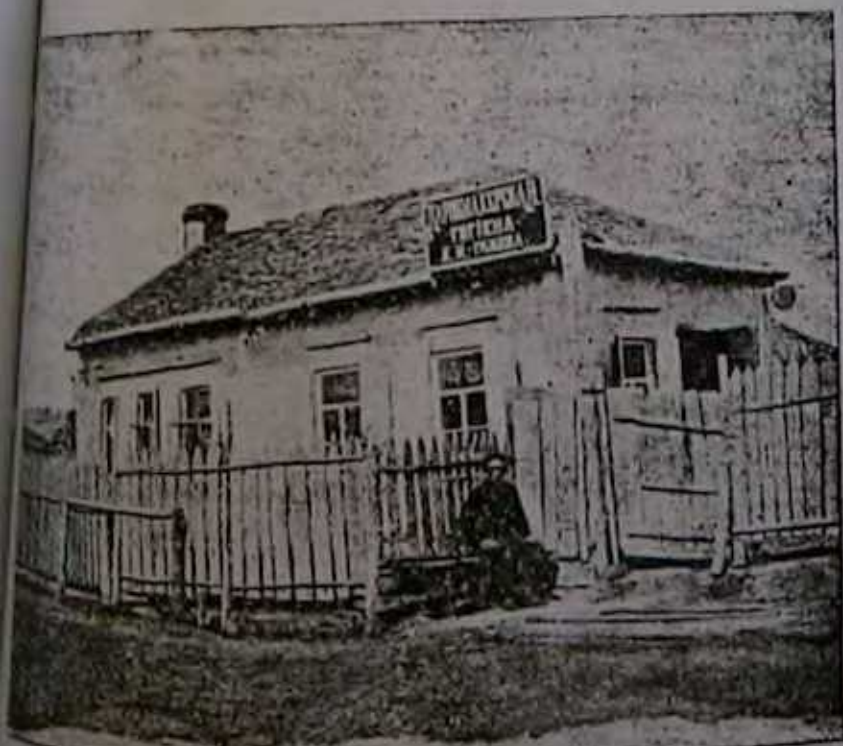
Тюкалинскъ. Образецъ мѣстной постройки, крытый пластами
