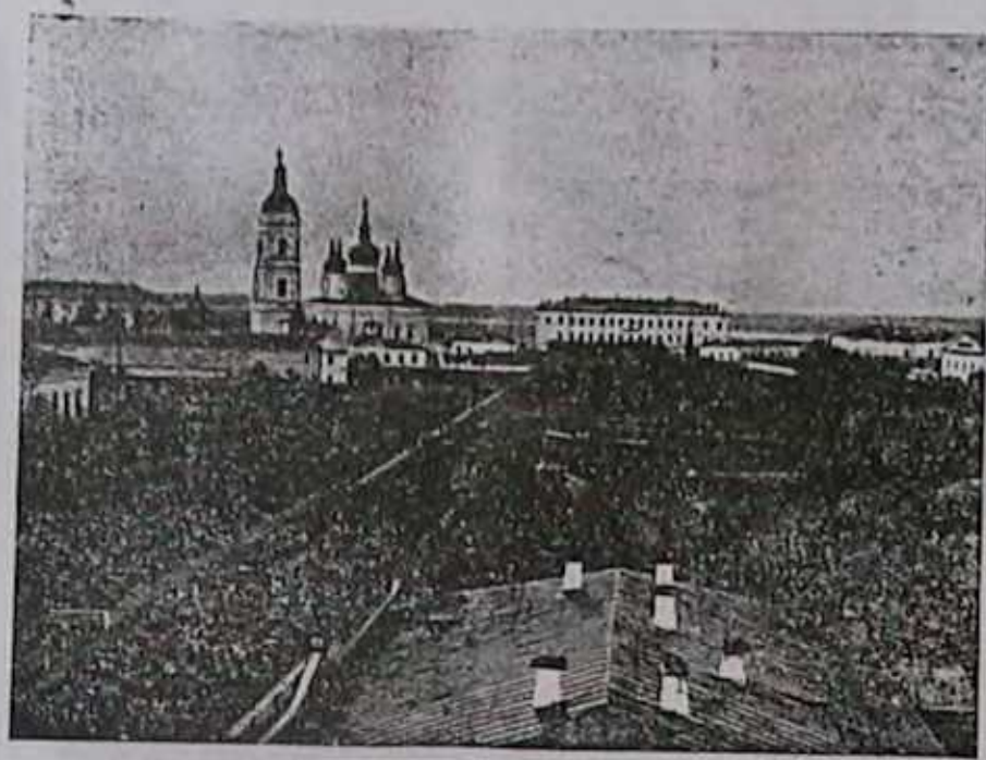
Тобольскъ, нагорная часть: архіерейскій домъ, соборъ, присутственные мѣста.
